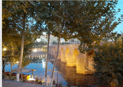
Diyarbakır-On Gözlü Köprü
